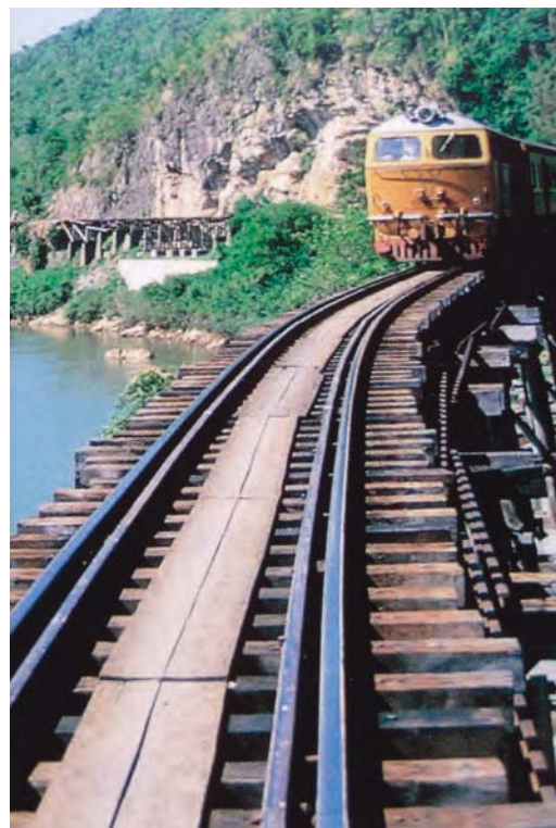
Über solche Konstruktionen verläuft ein erheblicher Teil der »Todesbahn«
