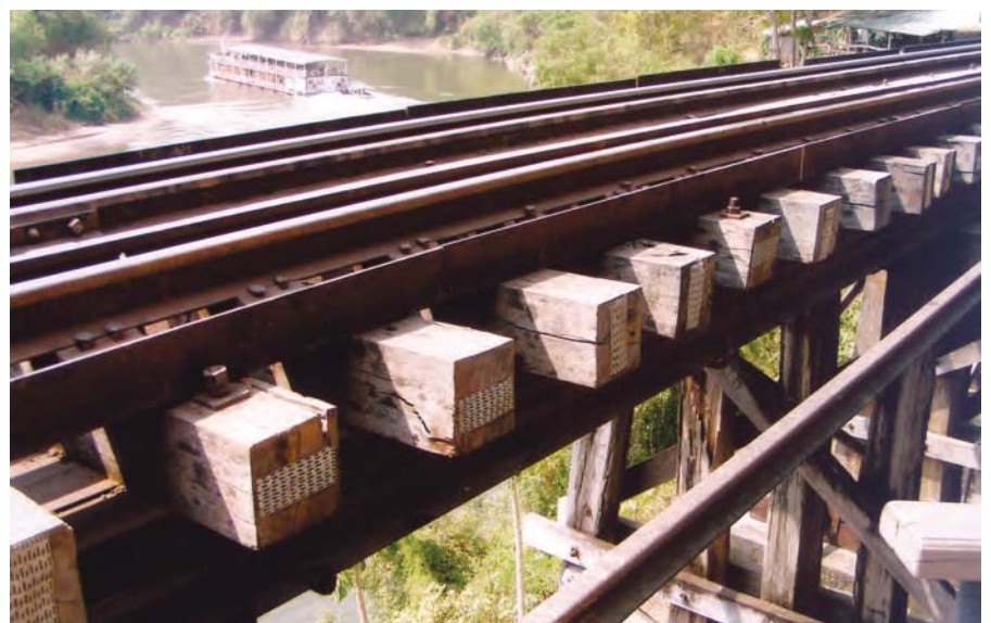
Zumindest die Schwellen sind erneuert worden!
