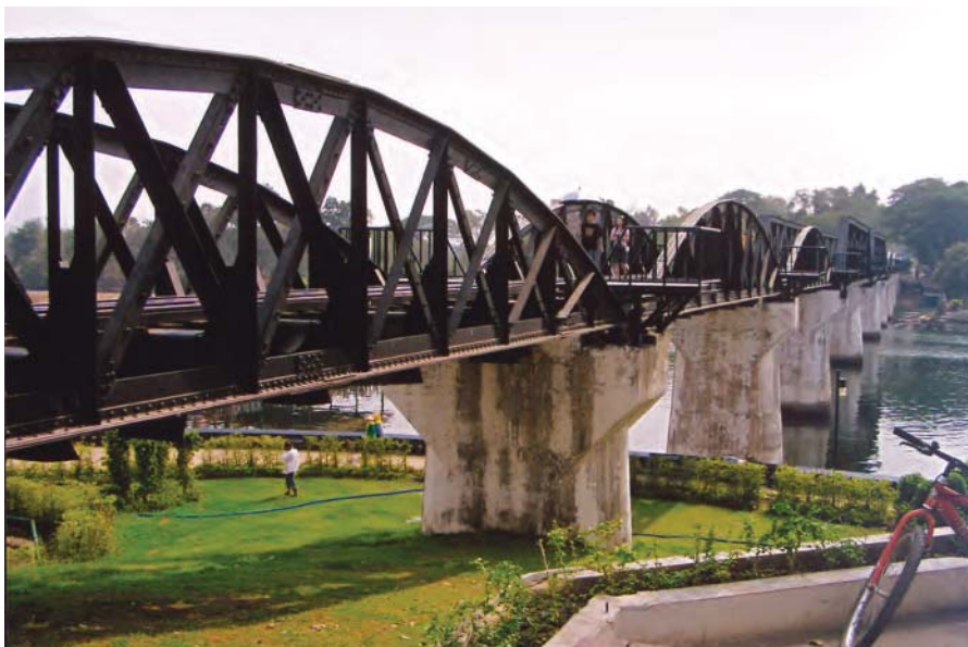
Die Brücke am KWAI. Diese Stahlkonstruktion ersetzte schon Anfang der 40er Jahre die filmbekannte Holzkonstruktion
