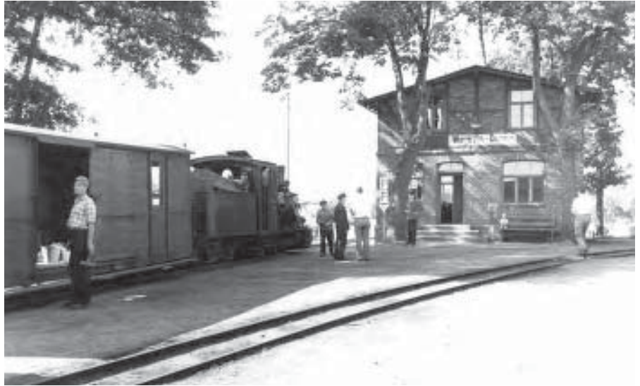
Unterwegsbahnhof Wegezín – Dennín mit abfahrerbereitem Personenzug nach Friedland Fotourheber: Rähr – Sammlung Pastowski, August 1966
