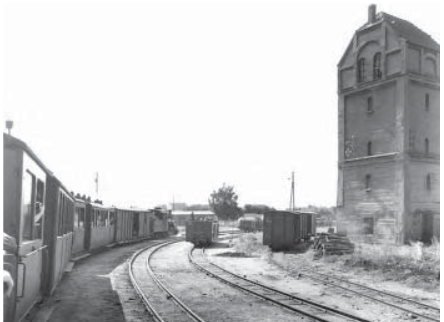
Aus- bzw. Einfahrgleise des Bahnhofs Friedland mit Personenzug in Richtung Wegezin-Dennin, rechts die ausgedehnten Gleisanlagen mit OOw's und GGw's
